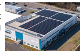
(株)アライドマテリアル(山形)の太陽光発電設備
