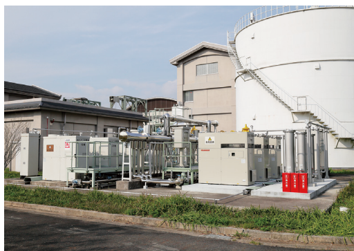
写真1 木津川上流浄化センター消化ガス発電設備
