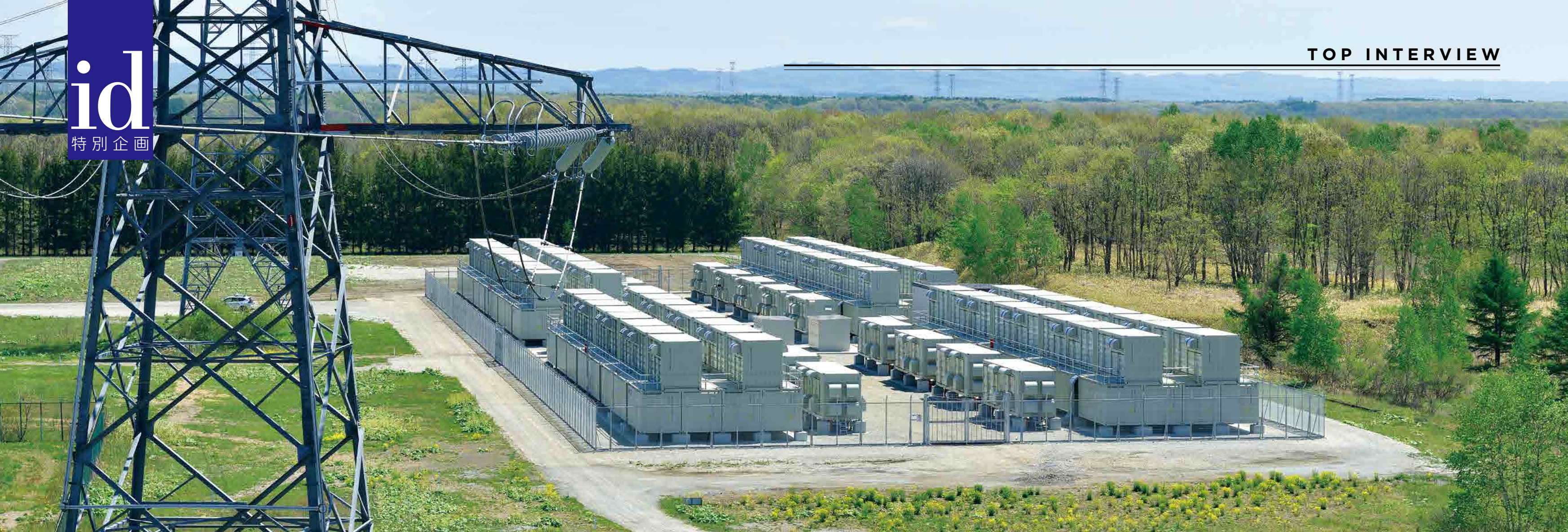
北海道電力ネットワーク南早来変電所に納入したレドックスフロー電池
