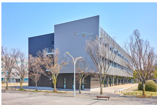
イノベーションアカデミース마트エネルギー棟 （写真提供：大阪公立大学）
