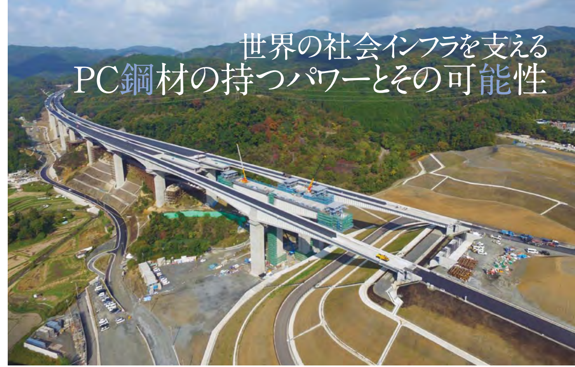
楊梅山高架橋 (写真提供:三井住友建設 (株))
