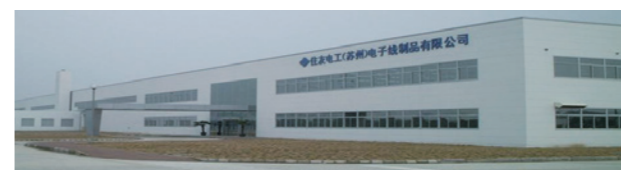
中国解析センターが拠点を置く Sumitomo Electric Interconnect Products (Suzhou) Ltd. (SESZ) の建屋
