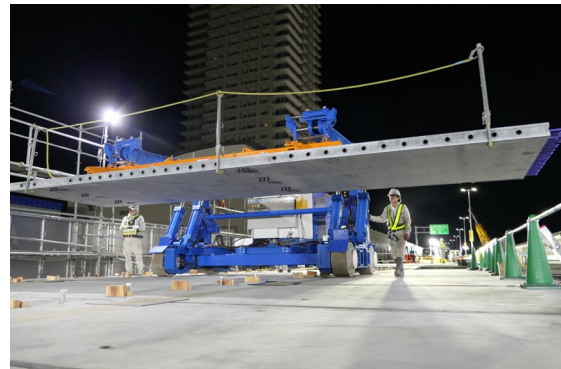
超高強度繊維補強コンクリート（UFC） *3 プレキャスト床版 [写真提供] 鹿島建設株式会社
