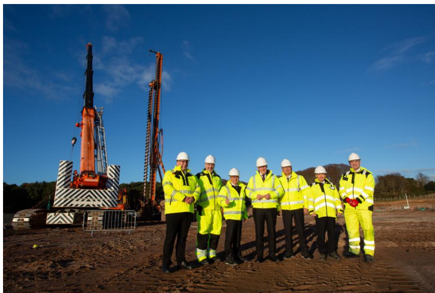
建設現場視察の様子
