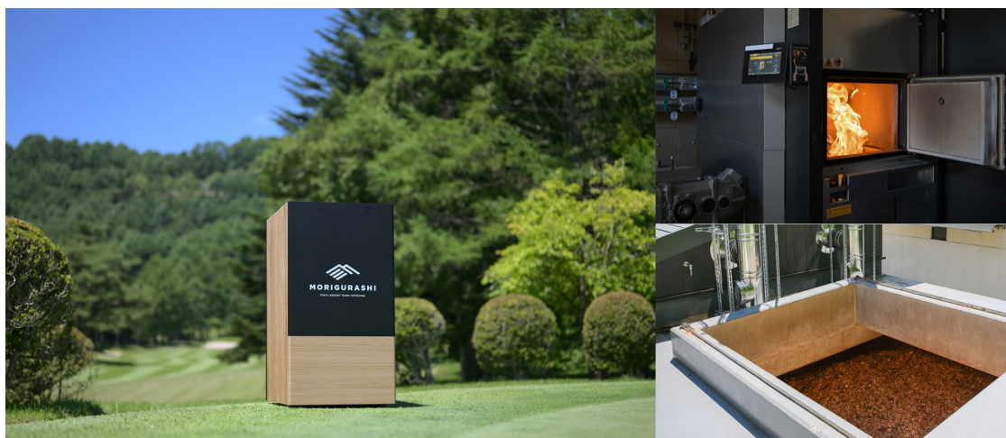
（左）CO 2 吸収・固定化装置 （右）バイオマスボイラーと燃料のウッドチップ
