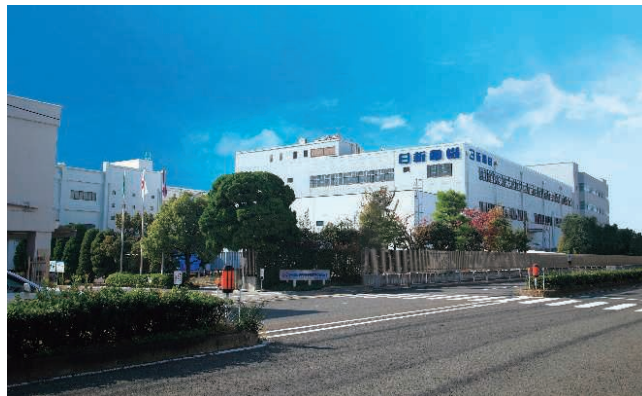
日新住電エネルギーシステム開発センターが入る社屋の全景
