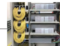
背面側でUターン配線。コード余長をクロス無く処理が可能。
