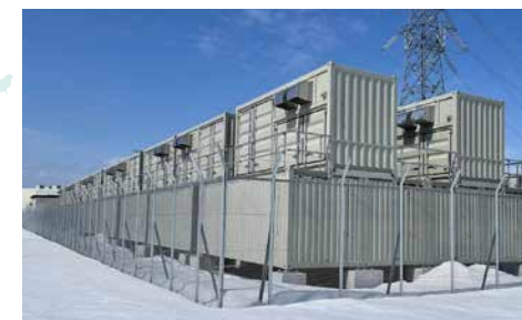
北海道電力ネットワーク株式会社向けレドックスフロー電池設備
