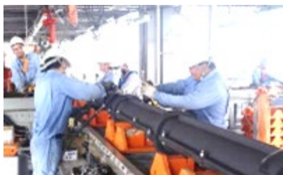
従来の敷設船上でのケーブル防護管取付例 (本事業で自動化・高速化の開発を予定)
