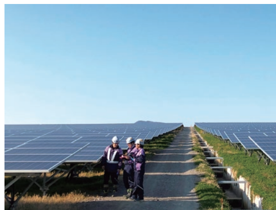
メガソーラーの施工の様子
