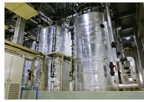
建屋内の電解液タンク
