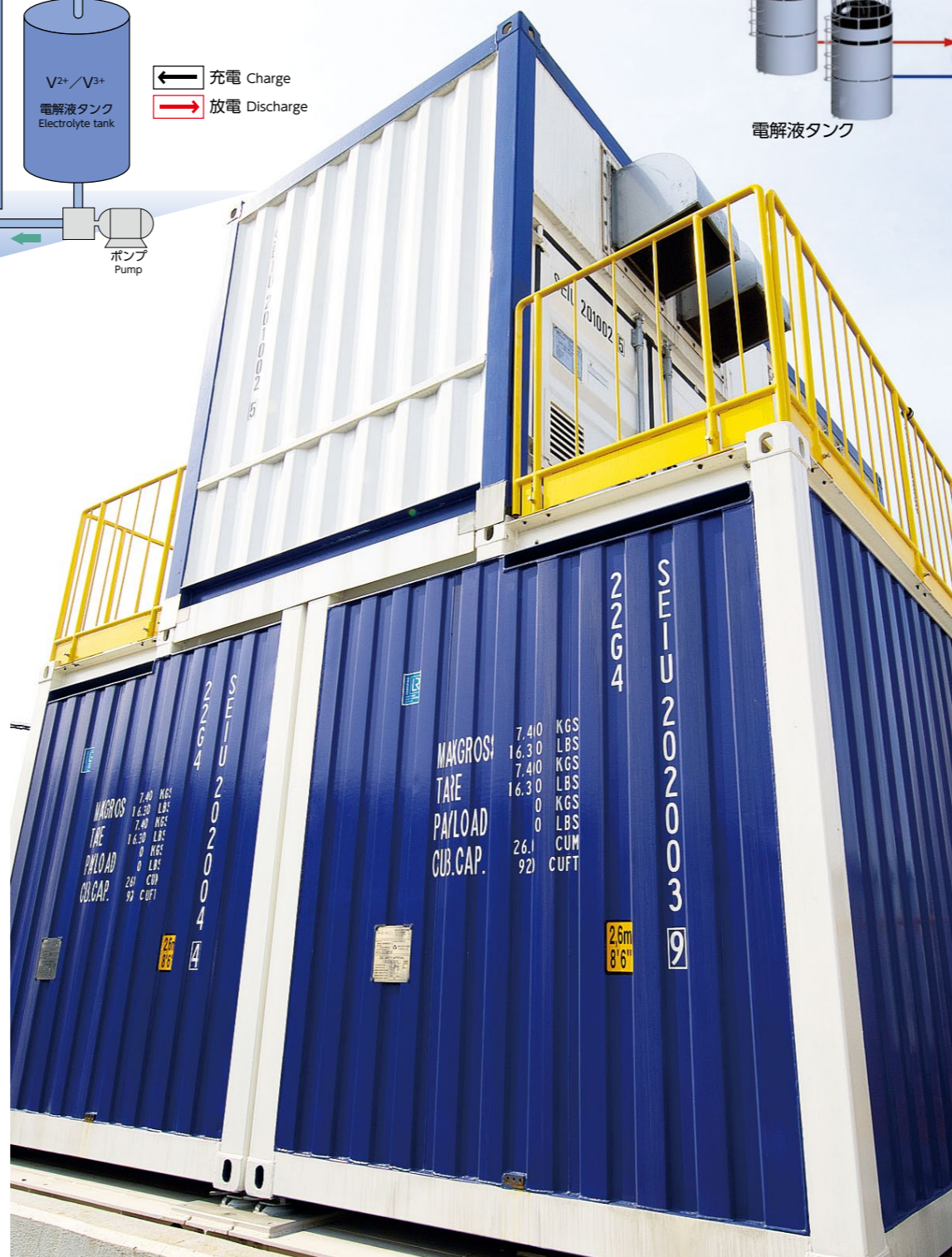
レドックスフロー電池は、1F部分に正極と負極の電解液コンテナ、2F部分にセルスタックが設置された電池盤コンテナで構成される
