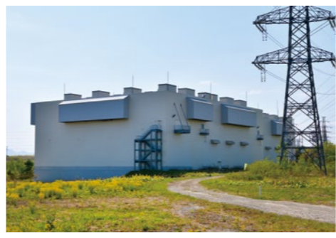
蓄電池建屋外観 2015年に北海道電力株式会社と共同で実施したレドックスフロー電池の大規模実証試験施設
