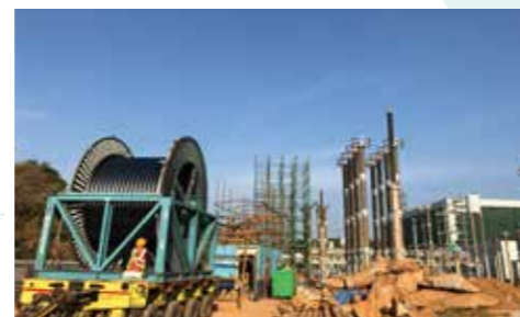
ケーブル布設の様子
