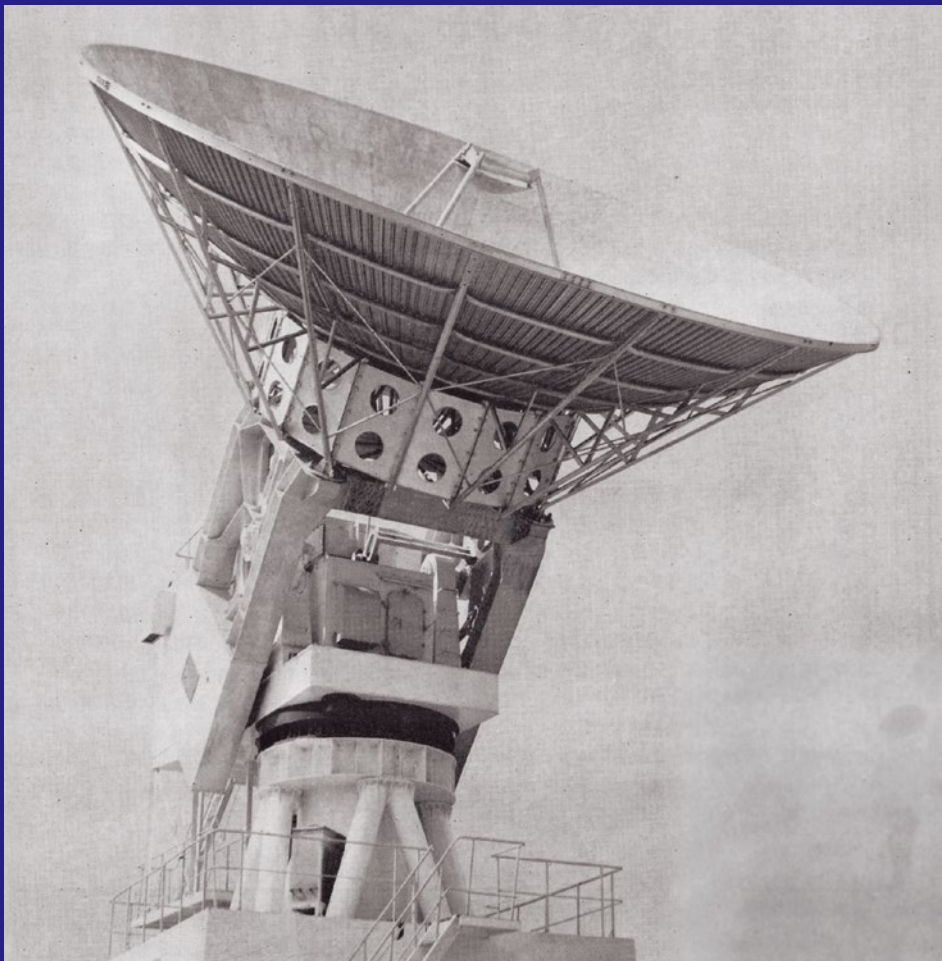
東京五輪をアメリカへ宇宙中継する茨城県鹿島町(当時、現・鹿嶋市)のシンコム衛星用のパラボラアンテナ(上のさかずき状の部分)
