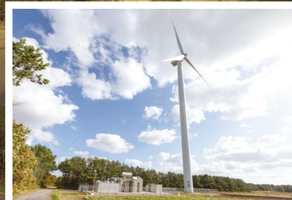
完成した風車と隣接する変電所
