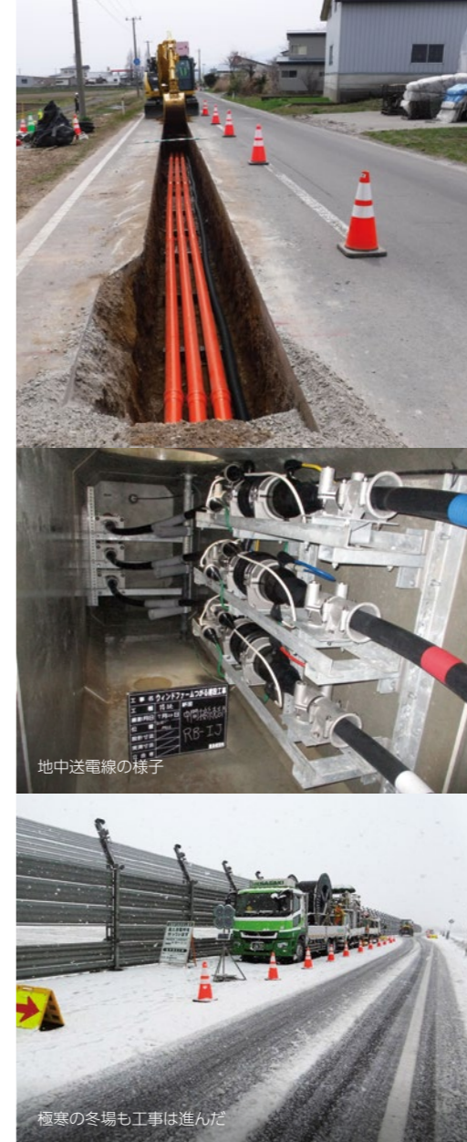
送電線の埋設工事風景
