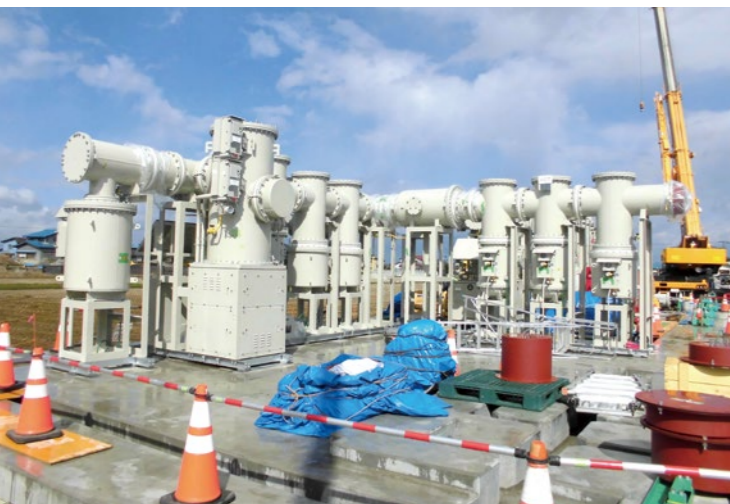
連系開閉所工事風景
