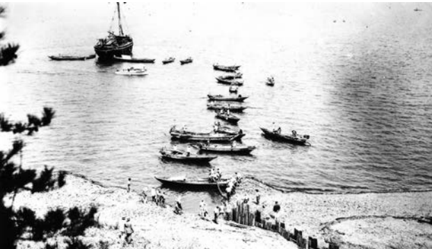
新居浜磯浦にケーブル端陸揚げ
