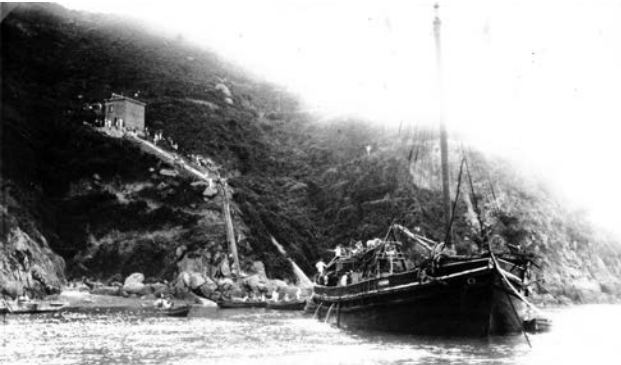
8月10日 四阪島にケーブル先端陸揚げ
