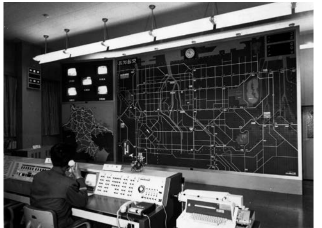
国内初の広域交通管制システム(福岡県警察本部)
