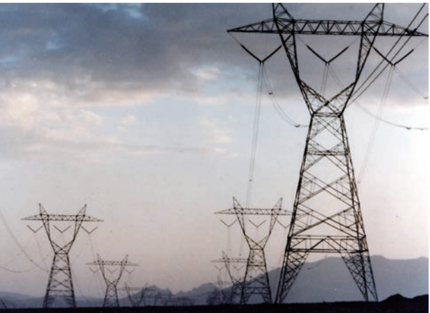
イラン送電線工事
