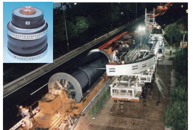
東京電力(株)新京葉豊洲線工事
