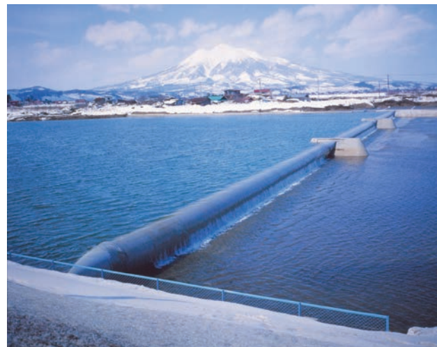
岩木川取水堰ファブリダム
