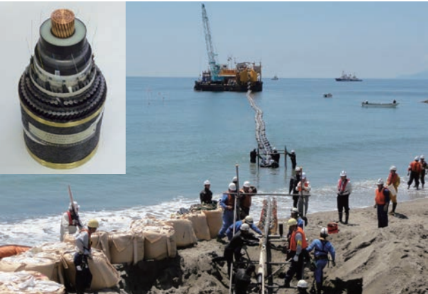
北本連系線(北海道一本州)工事
