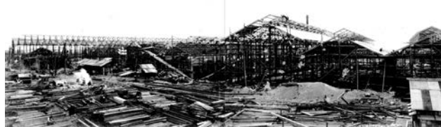
恩貴島工場建設
