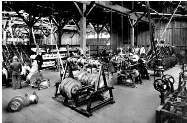
伸銅場ケーブル工場 (写真提供：住友史料館)
