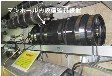
写真3 マンホール内設備監視装置
