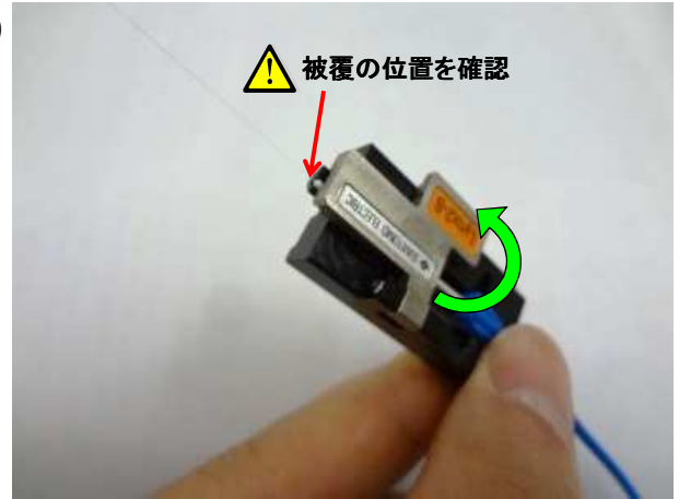
光ファイバ心線の被覆位置を確認し、ファイバホルダのフタを閉じる。
