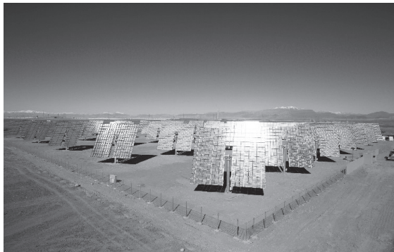
写真2 ワルザザートのメガワット級CPVシステム全景
