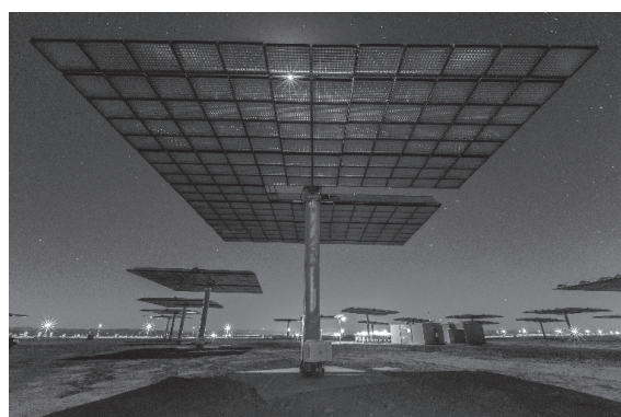
写真5 反転機能を用いて受光面を下向きにした夜間待機姿勢
