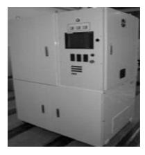
写真1 アンモニア除害装置の外観
