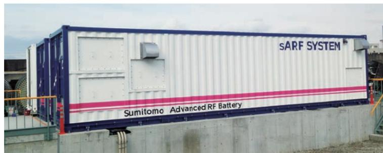
再生可能エネルギー発電を利用する電力システムでは、その発電量の変動に応じて電力を貯蔵・放出する蓄電池の役割が特に重要になります。レドックスフロー電池は、不規則で変動の激しい充放電運転に適し、貯蔵電力量の正確な監視・制御が可能なることから、
