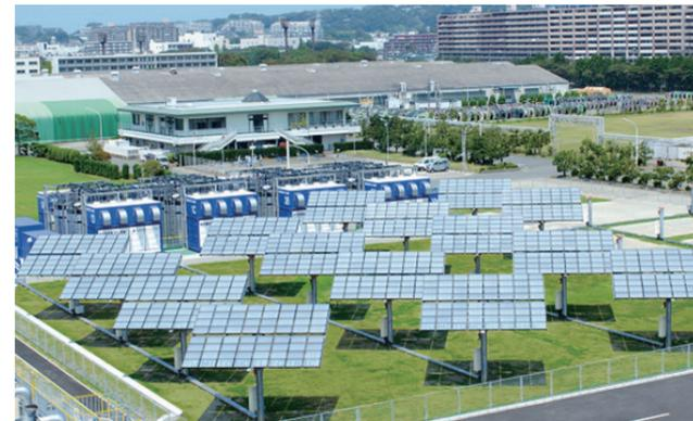
集光型太陽光発電装置(CPV)は、発電素子に特殊な化合物半導体材料を用いていることから、発電効率が市販のシリコンパネルに比べて約2倍であり、また集光パネルを地面から高い位置に設置する構造であり、パネル下のスペースも活用できるなど、次世代の太陽光発電装置として期待されています。当社が開発したCPVでは、従来のCPVに比べ、パネルの薄型化・軽量化を実現しています。
