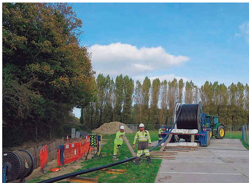
ケーブル敷設の様子（イメージ）
