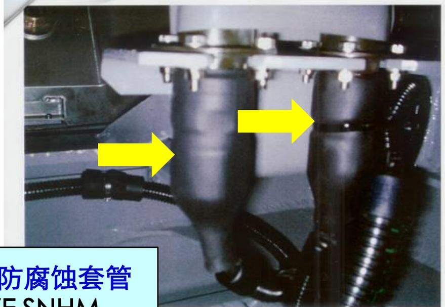
带内层胶的防水·防腐蚀套管
