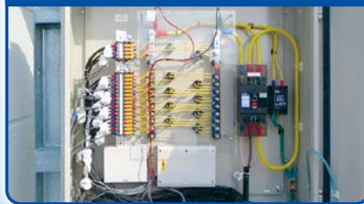
电力线通信 (PLC)
