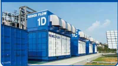
全钒液流电池
